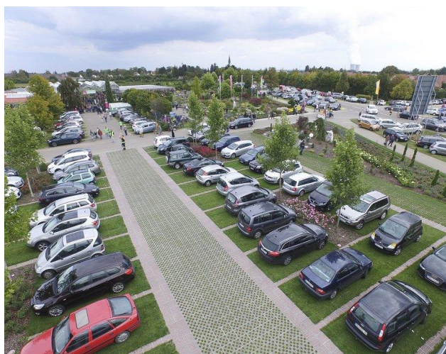
Obrázek A.6.5 - Parkoviště ze zasakovacích roštů (vlevo) a vsakovací průleh u Masarykovy univerzity v Brně (vpravo)
