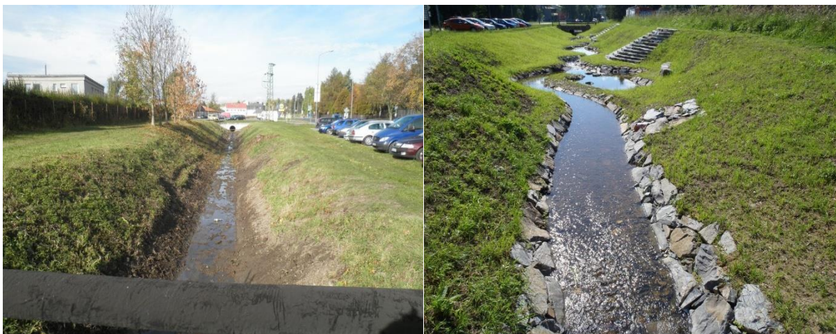
Obrázek A.5.2 - Revitalizace Kobylího potoka v Bruntále v rámci programu „Vracíme vodu lesu“ – stav před (vlevo) a po (vpravo) revitalizaci
