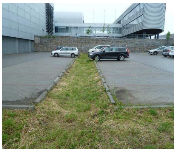
Obrázek A.6.5 - Parkoviště ze zasakovacích roštů (vlevo) a vsakovací průleh u Masarykovy univerzity v Brně (vpravo)
