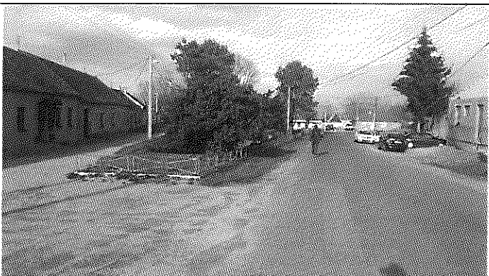
Nevzhledné oplocení veřejných prostranství (lépe je veřejnou zeleň neoplocovat vůbec) a velké množství elektrických kabelů v ulicích.
