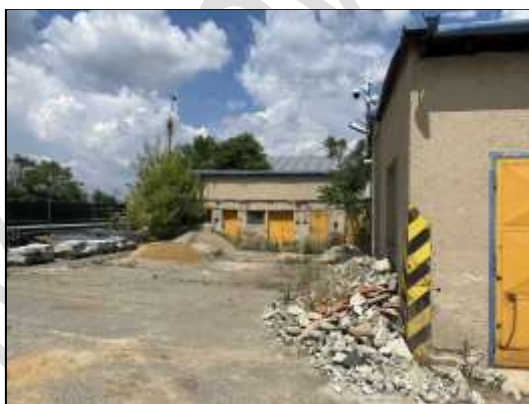
Obrázek 21 Stavební suť a materiál v okolí objektu
