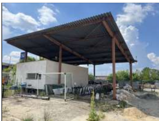
Obrázek 19 Přístřešek a uložené vybavení/materiál v areálu
