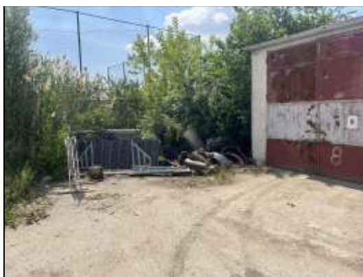
Obrázek 12 Volně uložené konstrukce a materiály u objektu
