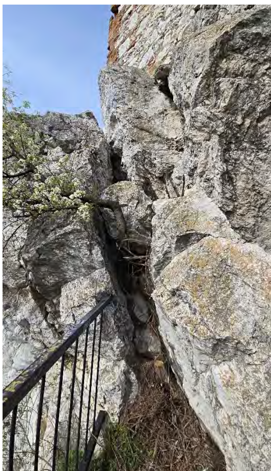
Obrázek 40: detailní pohled hlavní poruchové partie východní části masivu sektoru VĚŽ, s výrazně narušující náletovou vegetací a celkově strukturně narušenými bloky, vpravo zbytky předchozích postupů stabilizace vyzdívkami, některé pukliny jsou již takřka na hranici průleznosti (pouze pro velmi zdatné speleology či děti)
