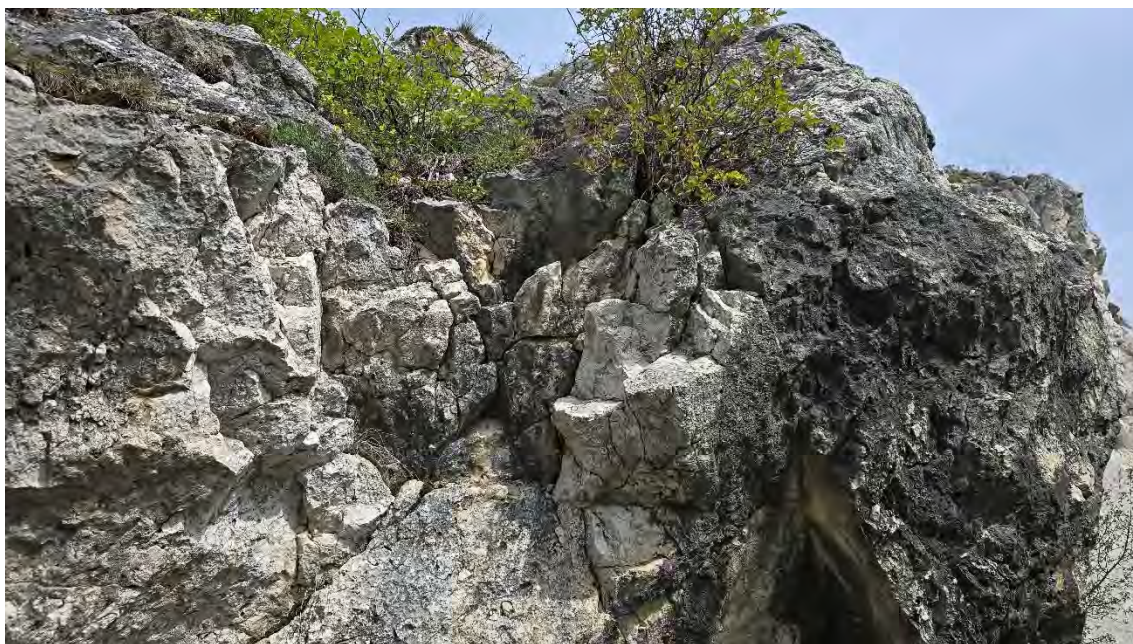
Obrázek 25: příklad narušených partií masivu v sektoru JIH ve výšce cca 2,7 m nad stezkou procházející po okraji sektoru, potenciálně rizikové místo
