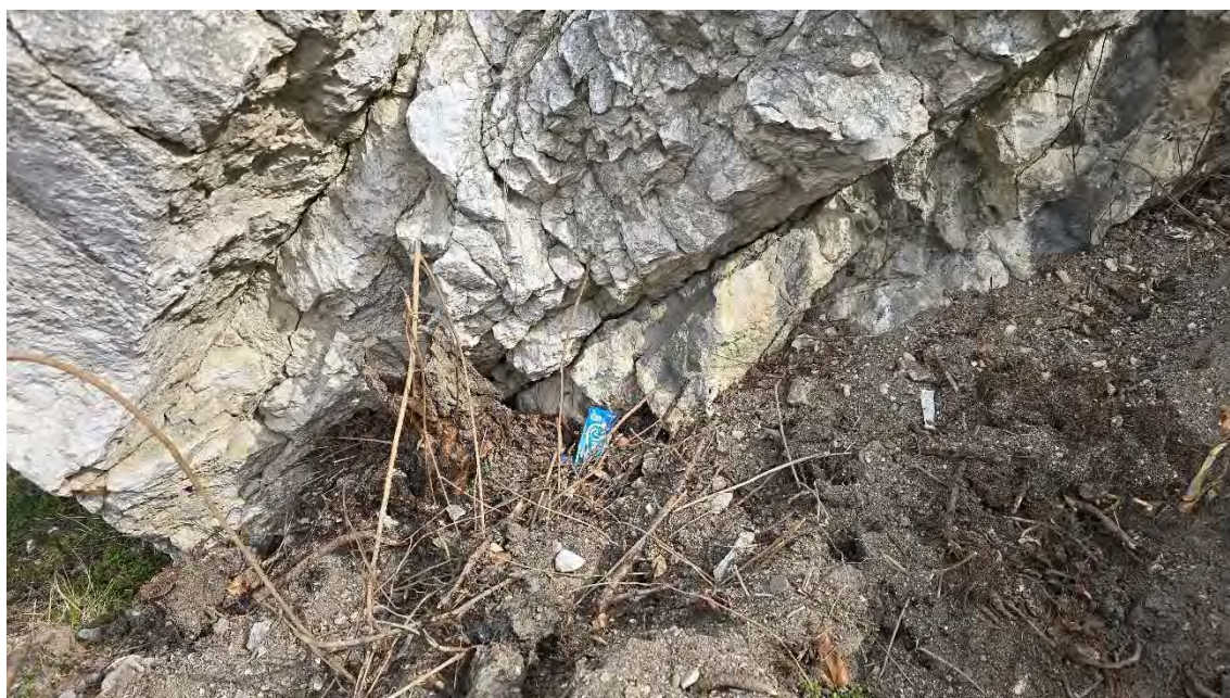
Obrázek 26: detail paty masivu s rozevřeným puklinovým systémem, který částečně sleduje i plochy sedimentace
