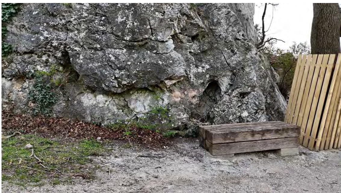
Obrázek 16: pohled na spodní partie masivu sektoru SEVER s projevy krasové činnosti (za dřevěným posezením) a odvětrávání masivu podél ploch odlučnosti
