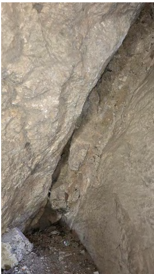
Obrázek 43: porucha na východní straně objektu, nejvýraznější porucha masivu, nyní oddělení na úrovni cca 15 – 30 cm, před 30 lety do 5 mm!
