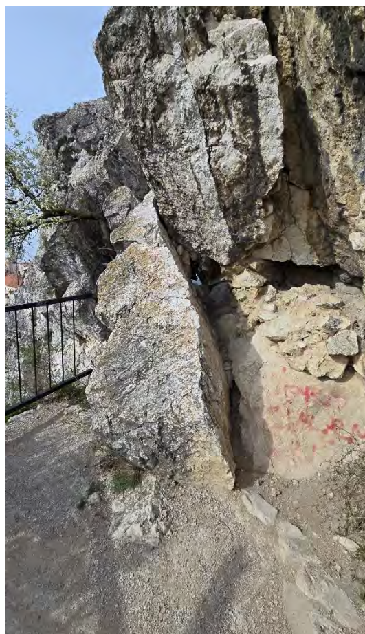
Obrázek 40: detailní pohled hlavní poruchové partie východní části masivu sektoru VĚŽ, s výrazně narušující náletovou vegetací a celkově strukturně narušenými bloky, vpravo zbytky předchozích postupů stabilizace vyzdívkami, některé pukliny jsou již takřka na hranici průleznosti (pouze pro velmi zdatné speleology či děti)
