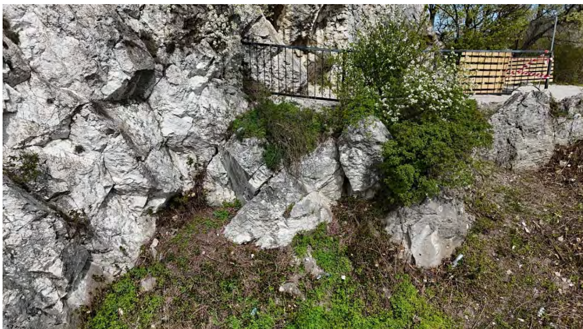
Obrázek 32: pohled na krajní partii sektoru VÝCHOD s pokryvem z hlinito kamenitých navážek, tyto navážky tvoří mocné podloží křovinatého porostu
