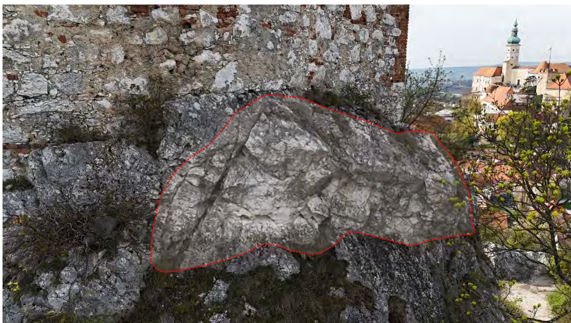
Obrázek 12: detailní pohled na rizikové partie sektoru SEVER, vyznačená riziková oblast s pozicí částečně oddělených od masivu a s potenciálem uvolnění a řízení, vyznačená oblast je v převisu masivu
